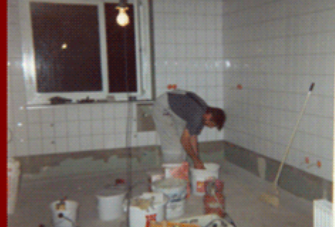
Aber trotz gerader Wände und kaum Verwinklungen in der Küche...
