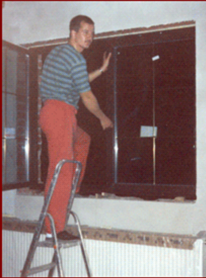
Jetzt folgte der Einbau der neuen Fenster
