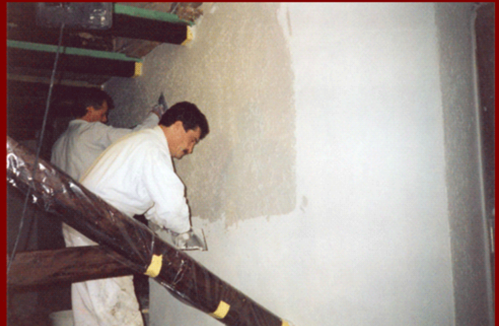
Die Putz- und Malerarbeiten übernahmen Thomas Gerber und sein Kollege.
