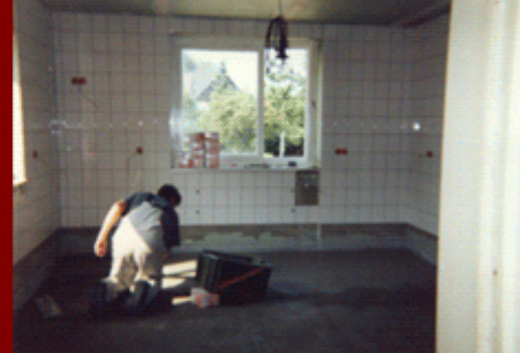
...dauerten die Fliesenlegearbeiten manchmal bis tief in die Nacht hinein.
